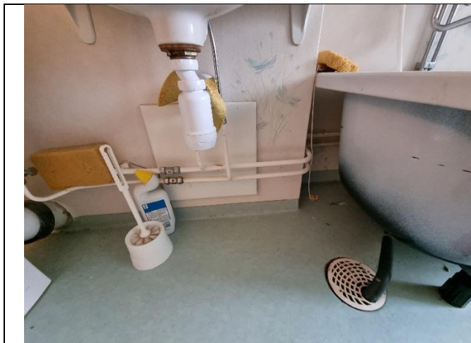
Ej godkänd inspektionslucka i anslutning till badkar, vanligt förekommande.
